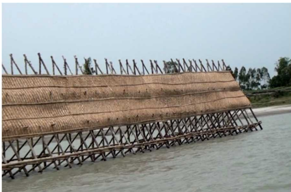
図1 伝統的河川工法バンダルリング
