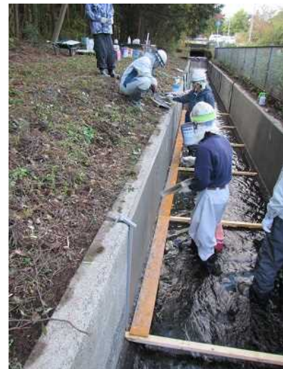
写真-1 実証試験用の施工の状況
