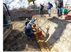
Fig.3 薄層段切り工法の施工の概略
