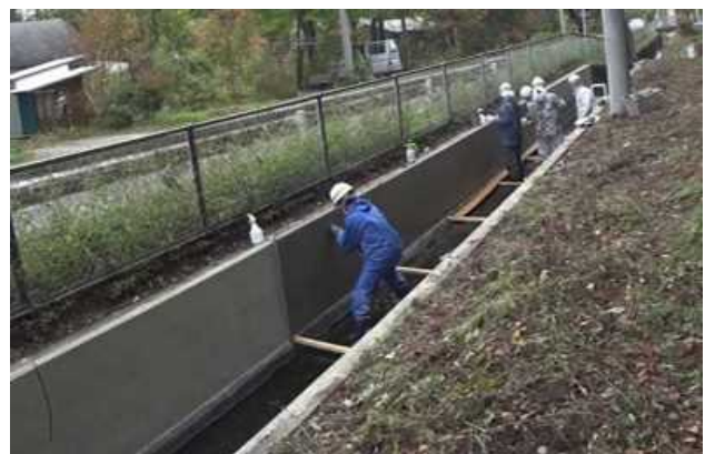
写真-1 実証試験の状況
